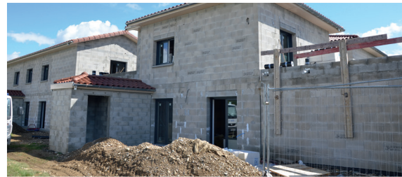
#1 - Construction en cours de 8 logements locatifs individuels sur la commune de Saint-Just-Chaleyssin. Livraison prévisionnelle : Octobre 2019
