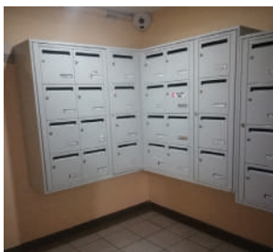
Remplacement des boîtes aux lettres, le Plan des Aures, Pont-Evêque
