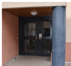
Remplacement interphonie et porte de hall, Mistral II, Vienne
