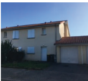
Réfection peinture des portes de garages, et des volets, Auberives-sur-Varèze
