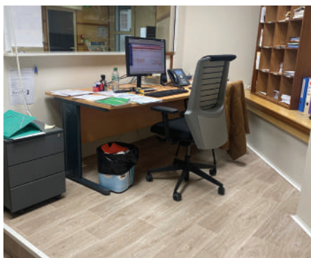
Réfection de l'antenne de Saint-Martin à Vienne
